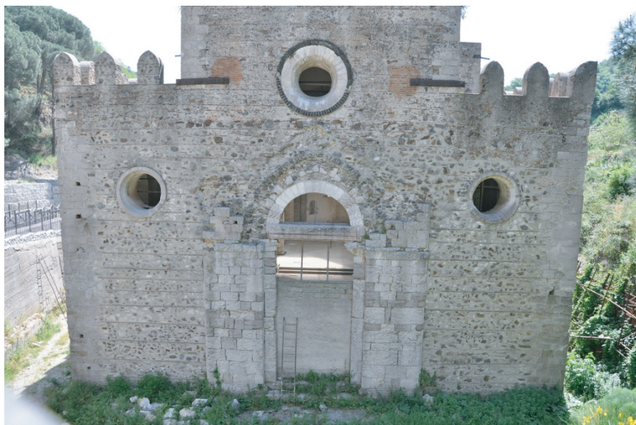
Figg. 24. Chiesa di S. Maria della Valle, 'Badiazza', prospetto principale
