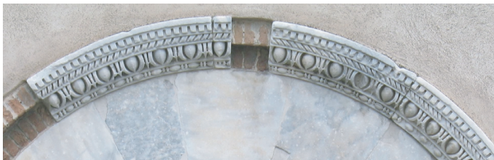
Figg. 27. Chiesa della SS. Annunziata dei Catalani, particolare del portale sinistro del prospetto principale
