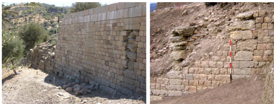
Fig. 6 - Alesa, muro di fortificazione, tecnica 'a telaio'.
